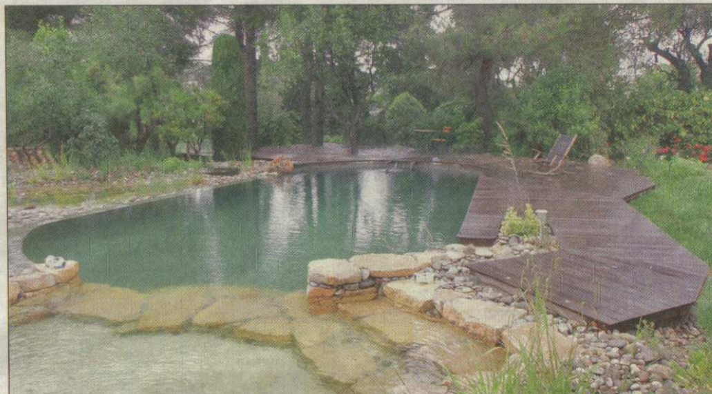
Ce bassin naturel a été créé à partir d'une piscine traditionnelle de 55 m 2 à laquelle a été greffé un débordement sur un espace de régénération de 50 m 2 , avec pataugeoire (1 er plan). L'étanchéité a été refaite avec un liner vert olive. (DR)
